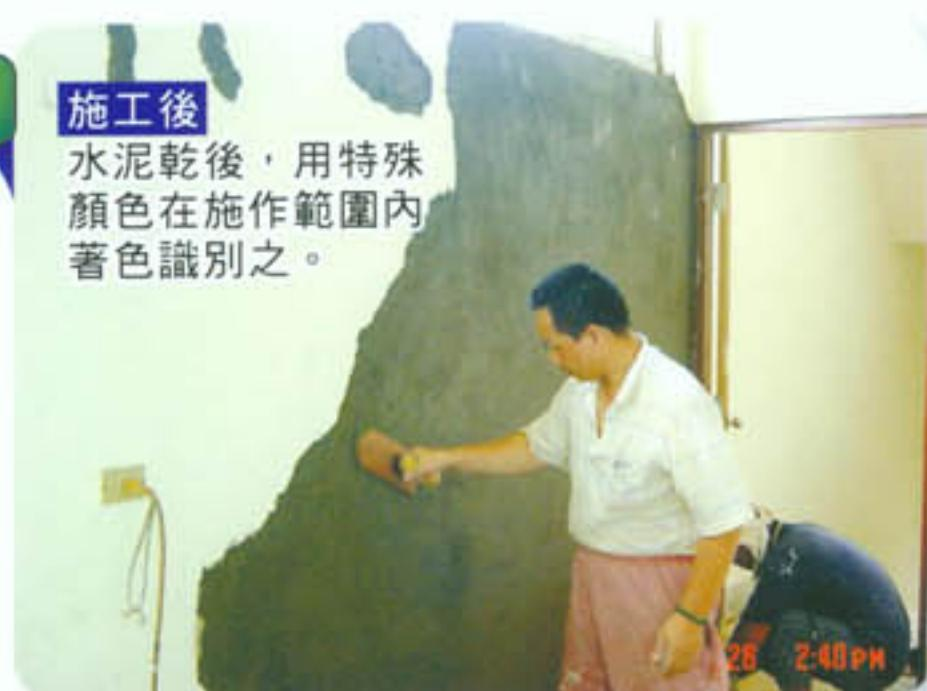
▲ 以水補快の『滲漏自癒砂漿』重新粉刷；不必再抓漏，永遠無壁癌。
