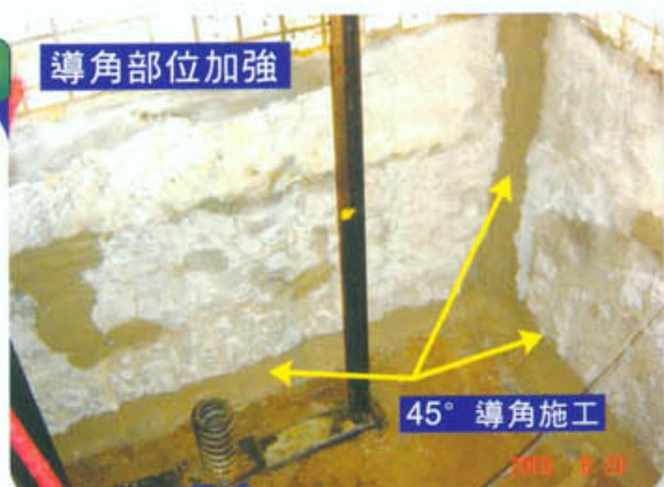
▲ 水補快滲漏自癒砂漿，作 45° 導角施工。
