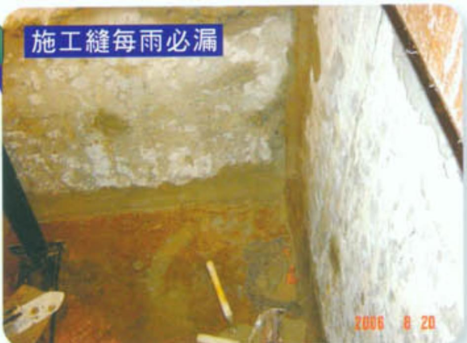
▲ 採用耐負水壓，能自癒的水補快自癒砂漿。
