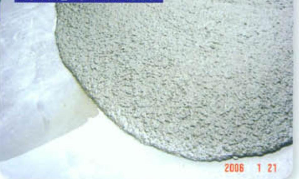
▲水補快滲漏自癒混凝土屋頂澆灌。
