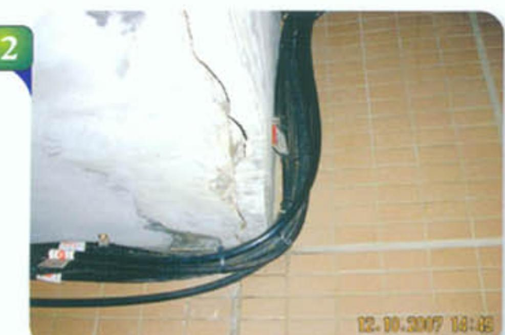
▲ 粉刷層破裂漏水。
