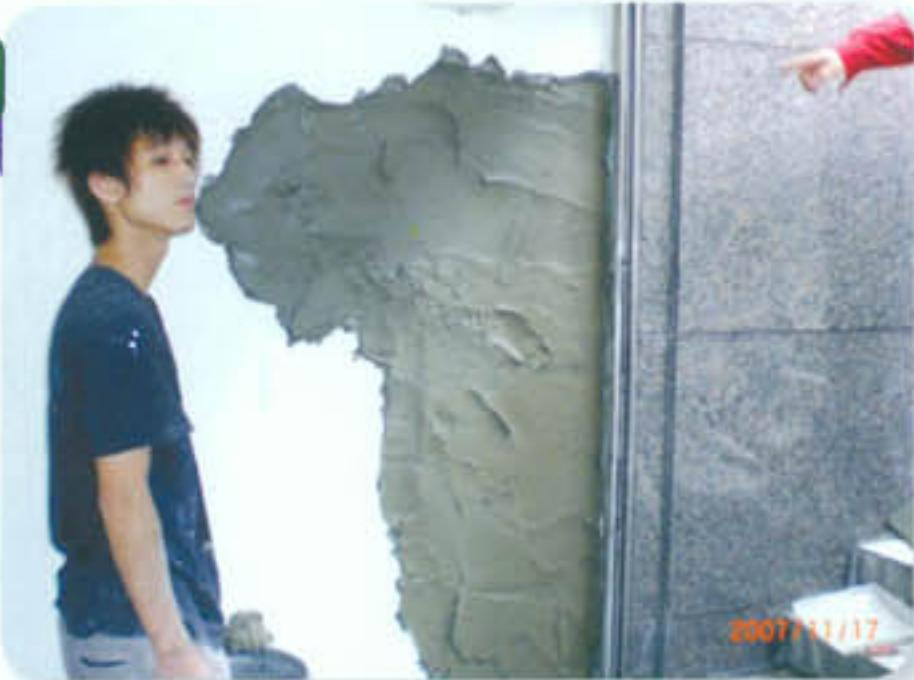
▲ 打除後以水補快自動抓漏砂漿粉刷復原。
