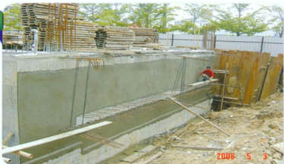
▲ 地下室外牆，水補快自癒砂漿防水粉刷。
