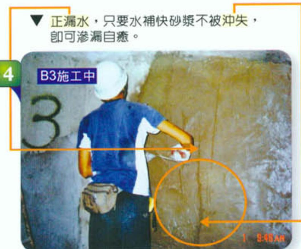
▼ 正漏水，只要水補快砂漿不被沖失，即可滲漏自癒。
