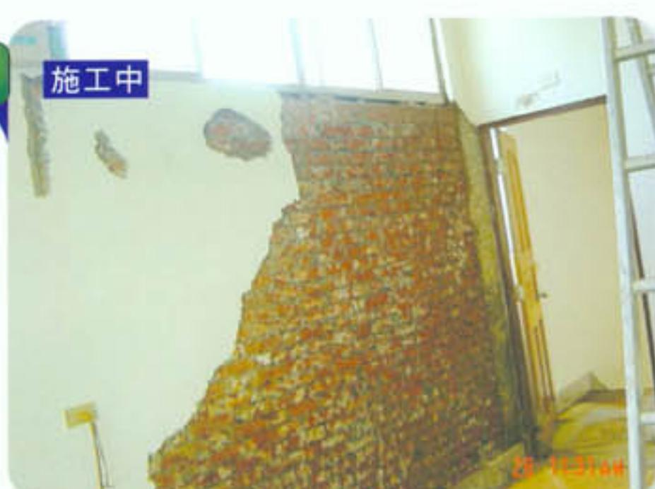
▲ 壁癌部位的水泥粉刷層，打除至結構面。
