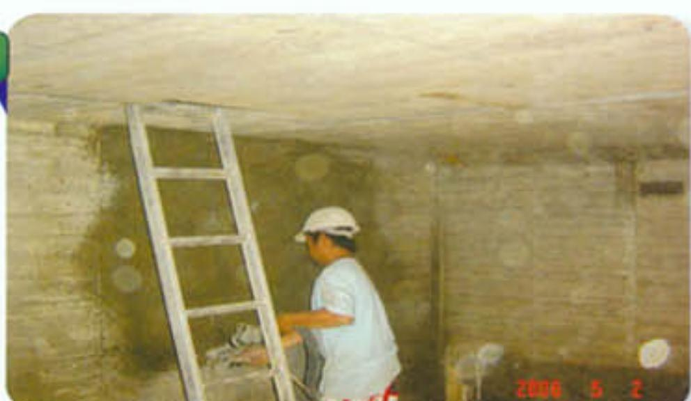
▲ 直接噴佈水補快の滲漏自癒砂漿。
