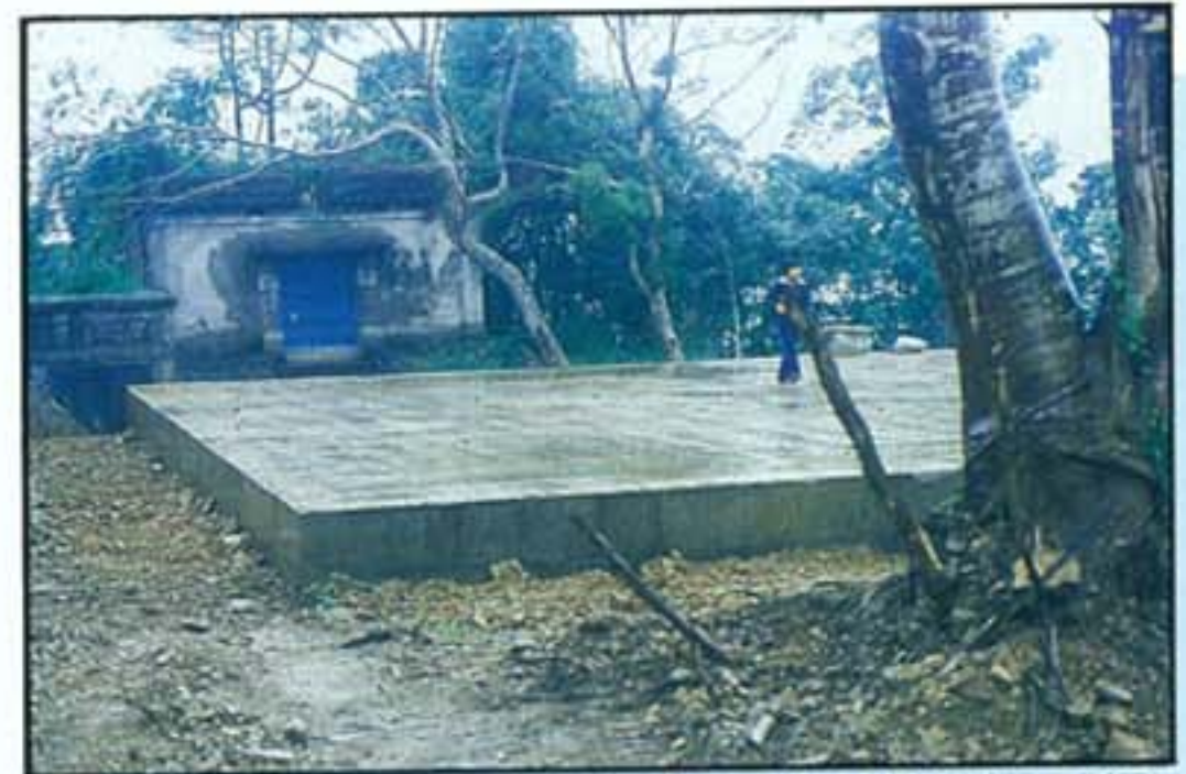
宜蘭圓山自來水廠表面粉刷防水工程
