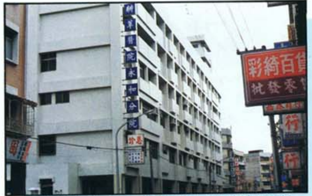
耕莘醫院永和分院地下室整體防水
