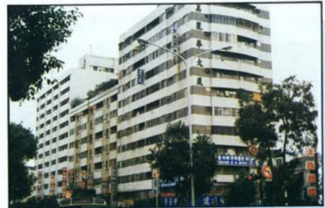
美麗華大廈使用表面粉刷防水
