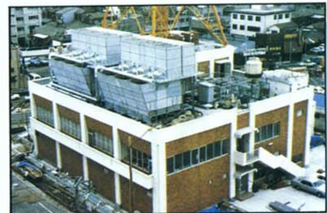
日本東電池上變電所
